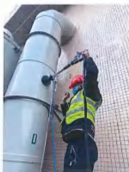
有组织废气 DA012 处理设施进气口
