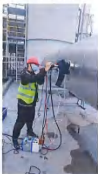
有组织废气 DA006 处理设施进气口 B
